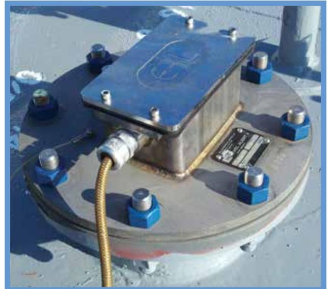
LEVEL ALERT II Nivel alto/sobrellenado Sensor de alarma de nivel de líquido instalado.
