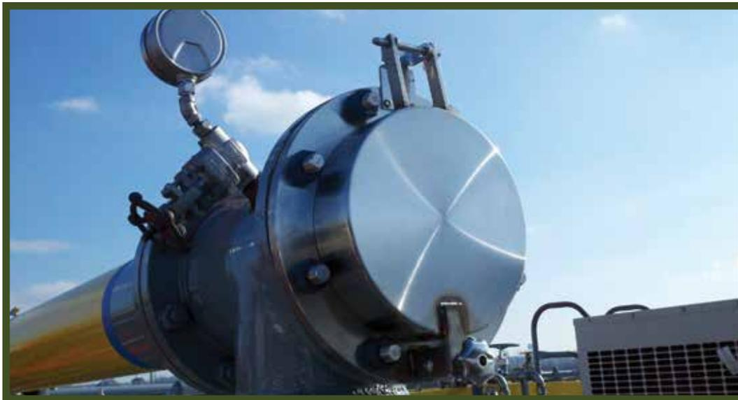
Típico respiradero de vapor con visor de respiradero de ERL y medidor de presión/vacío modelo 505 de ERL.
