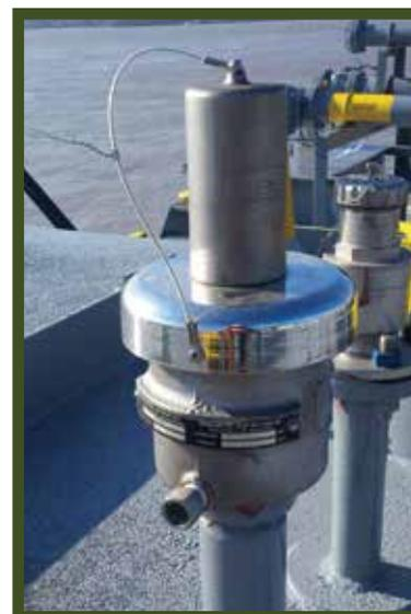
Válvula de presión y vacío Equate de 2.5" montada en una tubería vertical junto a una válvula de esfera de muestreador de 2".
