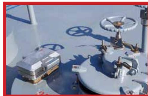
*Modelo de vista completa SGM-1 instalado en un domo de expansión adyacente a la válvula de cierre y a la tapa de acceso.*
