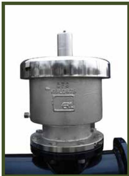
Válvula de presión y vacío Equate de 8" montada en un respiradero de vapor.
