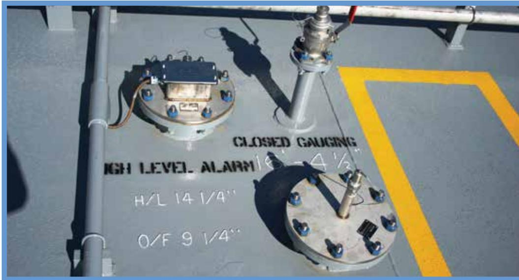
Alarma de nivel de líquido LEVEL ALERT MODELO II™ de nivel alto/sobrellenado Sensor, válvula de esfera de muestra y medidor de vara ascendente de un metro DS-39™.
