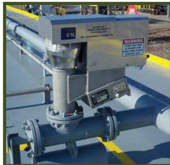
Válvula de presión y vacío de alta velocidad de acero inoxidable Superac de 6" modelo II sobre un respiradero de 8".
