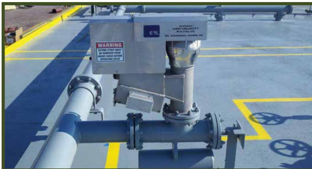
Válvula de presión y vacío de alta velocidad de acero inoxidable Superac de 6" modelo II montada en tubería plegable.
