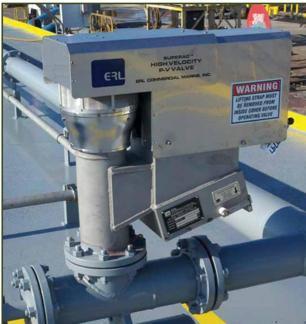
Válvula de presión y vacío de alta velocidad Superac de 6" modelo II montada en tubería de vapor plegable.
