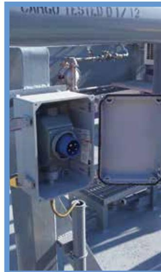
Conector barcaza a costa BTS-1 con BCS-001 ubicado afuera de una caja hermética Hubbell.
