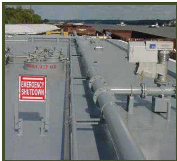
Válvula de presión y vacío de alta velocidad Superac de 6" modelo II montada en tubería plegable junto a un cartel de corte de emergencia (EMS-001) con marco de acero inoxidable (EMF-001).
